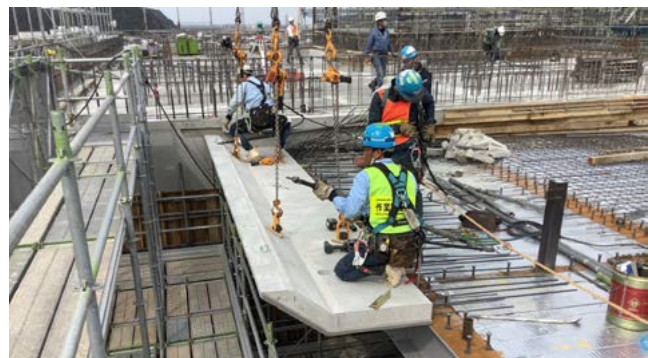
大屋根先端スラブのPC化
