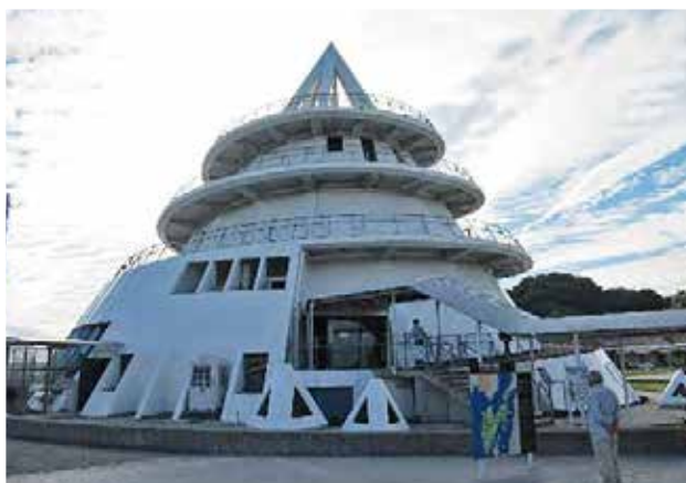
三角港フェリーターミナル
