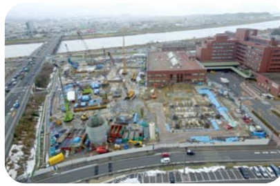
平成29年1月 杭工事施工中
