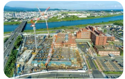
平成29年8月 2階施工中
