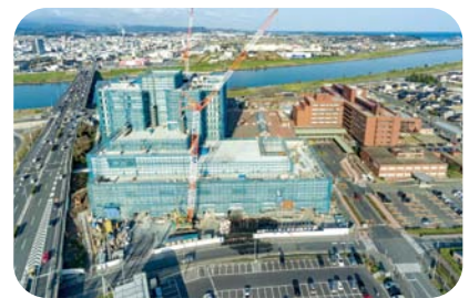
平成30年3月 外部仕上げ施工中
