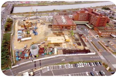
平成28年11月 工事着手
