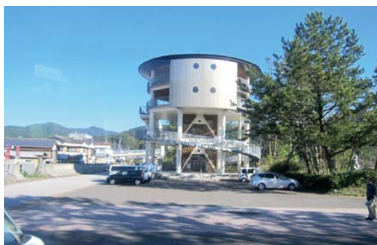
津波対策避難タワー
