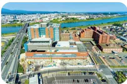
平成30年5月 内部仕上げ施工中
