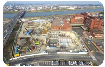
平成29年3月 地中水槽施工中
