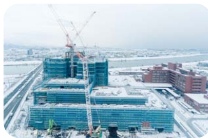
平成30年1月 鉄骨建て方完了
