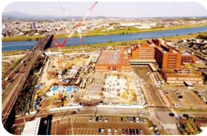
平成29年4月 1階施工中
