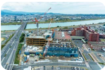
平成29年10月 6階施工中
