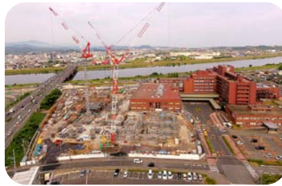
平成29年6月 鉄骨建て方開始
