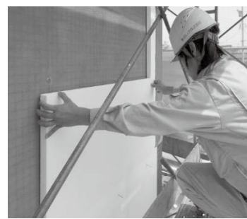
↑断熱材張り付け
