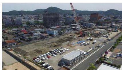
平成30年5月 免震装置施工中
