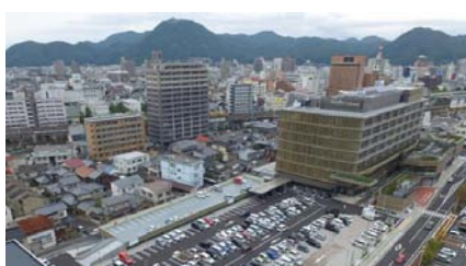
令和1年8月 竣工
