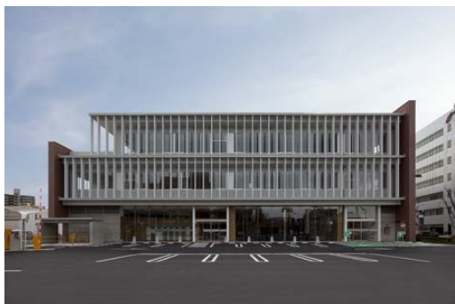
山陰合同銀行米子支店 所在地：米子市
