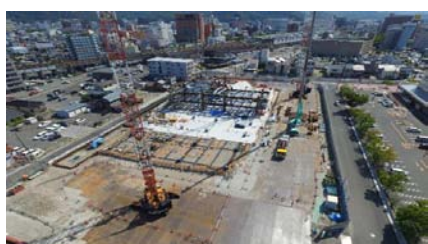
平成30年8月 2階施工中
