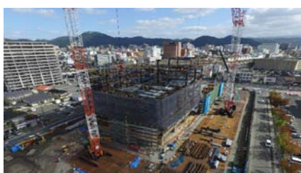
平成30年10月 庁舎棟西側最上階施工中
