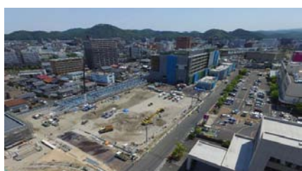
令和1年5月 庁舎・市民交流棟内部仕上げ 立体駐車場棟施工中
