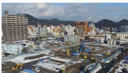
平成29年1月 庁舎棟杭工事施工中
