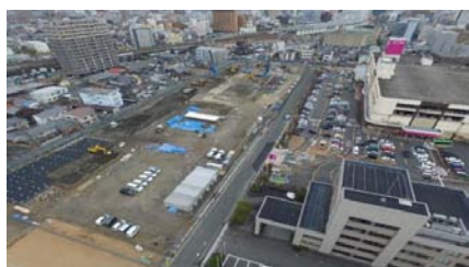
平成29年12月 庁舎棟工事着手
